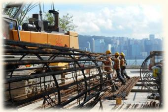
▲ 正在進行的地基建造工程,上圖為鑽孔灌注 樁鋼筋籠的裝嵌工序。
