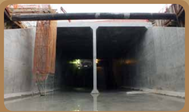
建造中的主隧道雨水排放點
