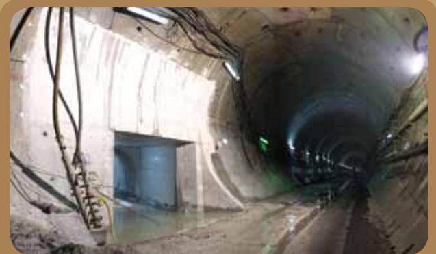
建造中的主隧道與連接隧道交匯點
