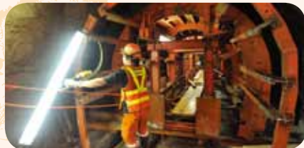
連接隧道內層建造工作進行中
