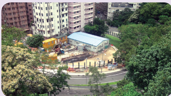
進水口SM1已完成建造。現正進行綠化工程及植樹工作。
