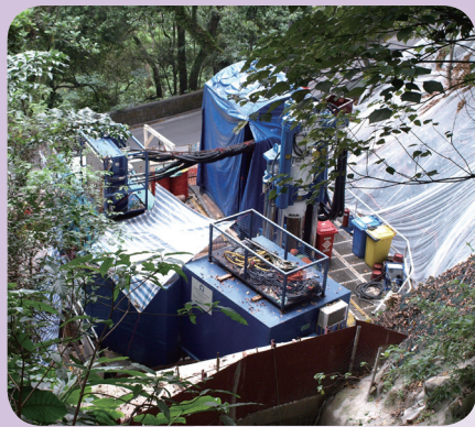
位於梅道的進水口編號M3現正使用反井鑽機進行豎井挖掘
