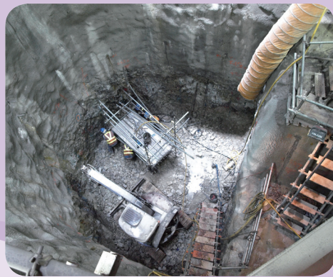
位於堅尼地道的進水口編號BR6現正進行豎井挖掘工程
