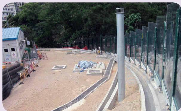
進水口編號SM1附近已安裝透氣喉，用以釋放雨水流入豎井時所產生的空氣
