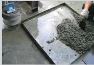
製造預製件之混凝土的溫度不能超出攝氏32度
