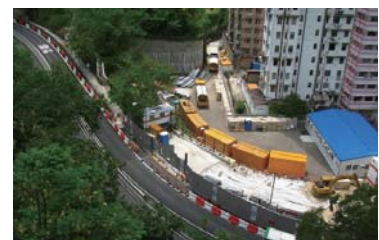
士美菲路旁的進水口(編號SM1)的工地情況
