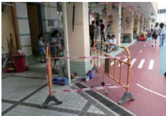
爆破工作進行時，工程人員在附近進行震盪監察
