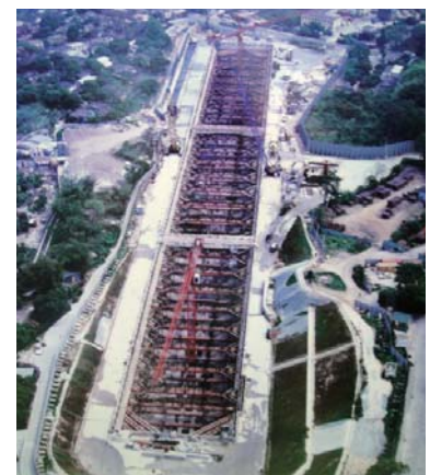
在港鐵落馬洲支線的工程中，位於上古洞的隧道以明挖回填法建造
