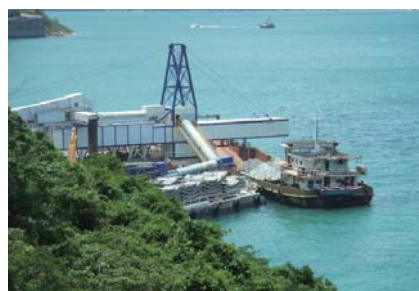
數碼港隧道西面出口以密封式輸送系統運走碎石
