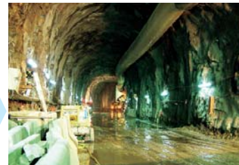
主隧道的東面一段以鑽爆方法挖掘
