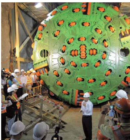
渠務署署長劉家強先生向傳媒講解隧道鑽挖機的裝嵌及運作
