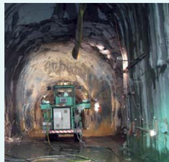
隧道東面入口 - 起始隧道爆破工程
