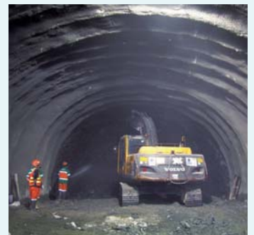
隧道西面出口 - 起始隧道挖掘工程
