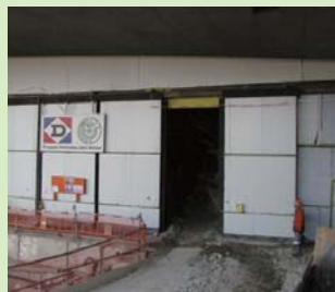
隧道西面出口(近數碼港) - 起始隧道的隔音屏障
