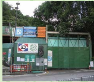
隧道東面入口(大坑道) - 工地範圍已設置圍板
