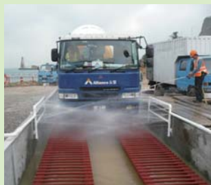
隧道西面出口(近數碼港) - 工地範圍設有清洗車輪設施
