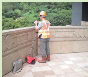
承建商定期在不同工地進行噪音量度
