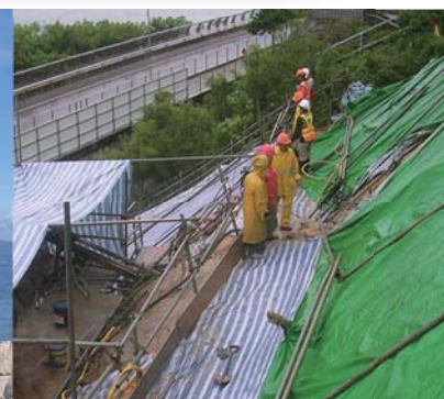
主隧道西面出口- 斜坡鞏固工程
