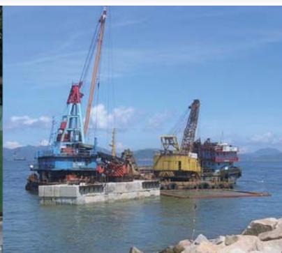
主隧道西面出口- 臨時碼頭工程
