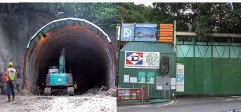
主隧道東面入口- 機械式隧道挖掘工程
