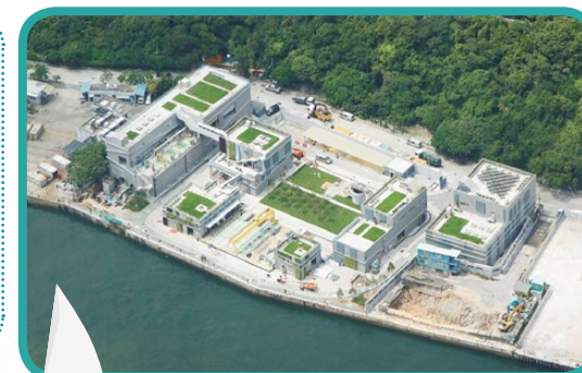
梅窩污水處理廠 Mui Wo Sewage Treatment Works
