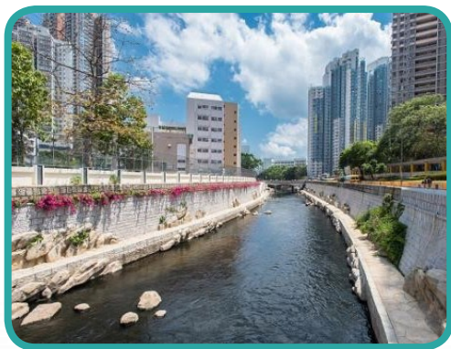
活化後的啟德河 Kai Tak River after revitalisation
