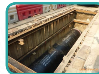
在翔東路實施臨時交通措施下進行明坑敷設渠管工程
