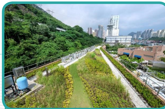
香港仔基本污水處理廠天台綠化工程 Roof greening at Aberdeen Preliminary Treatment Works
