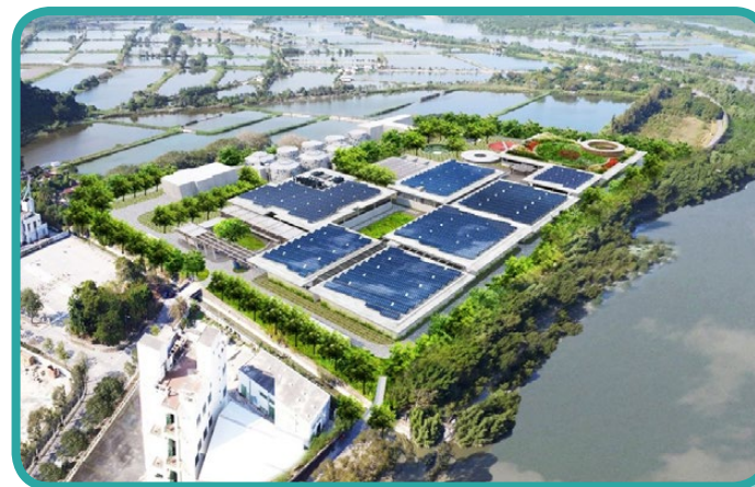
元朗淨水設施設計圖 Design layout of Yuen Long Effluent Polishing Plant
