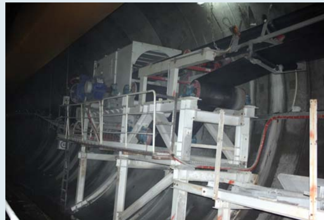
鑽挖隧道內之增壓機
