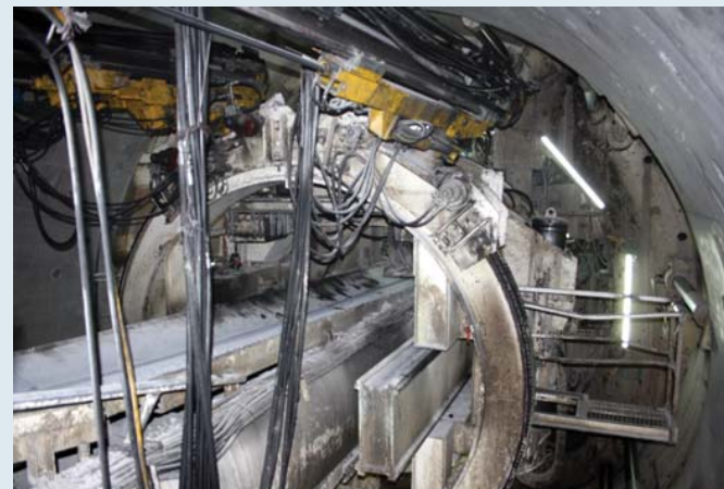
隧道鑽探機械及運出石料
