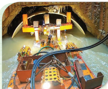
應用遙控機械人於運作中的污水幹渠內鋪設喉管
